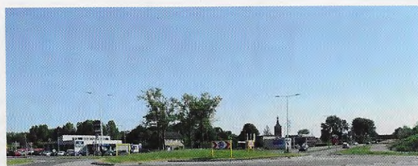
Locatie gezien vanaf de Zwartsluizerweg
